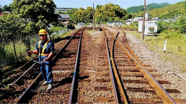
第4図 雑草の機械的防除、土讃線179.400km付近
